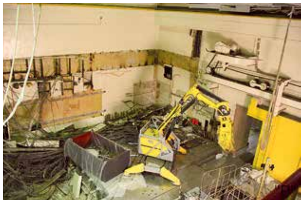
Рис. 3. Расположение дистанционно управляемых механизмов и их операторов при выполнении радиационно опасных работ
