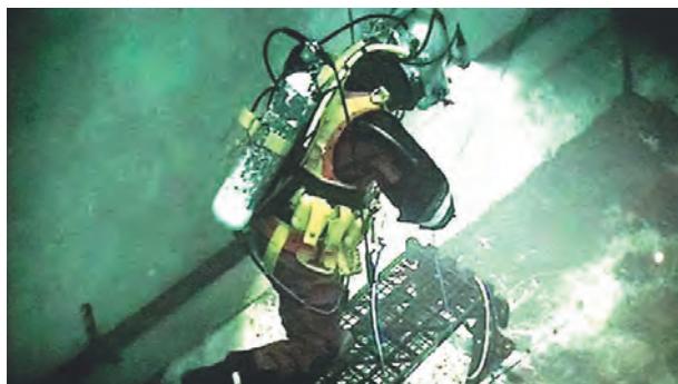
Рис. 1. Подводный демонтаж с привлечением дайверов в бассейне-хранилище ОЯТ на площадке АЭС Сайзвелл А
