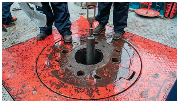
Рис. 3. Подготовительные работы по погружению контейнера-прототипа с имитатором РАО в скважину захоронения с его последующей установкой в горизонтальную секцию пункта захоронения
