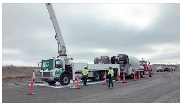
Рис. 5. Выполнение работ по цементированию тоннеля захоронения РАО в Хэнфорде
